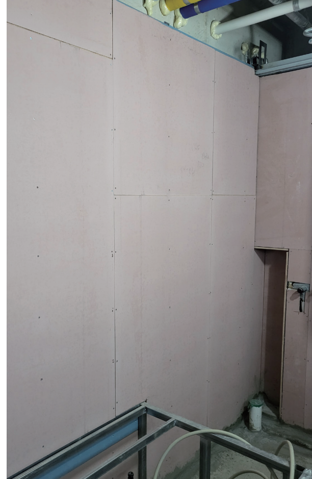
월데크 시공 | 2층 화장실 내
