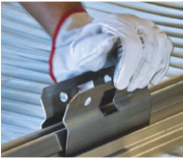
스노우가드, Suport Clamp 설치
